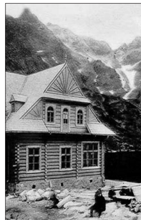
Lato 1908 – ostatnie dni budowy
